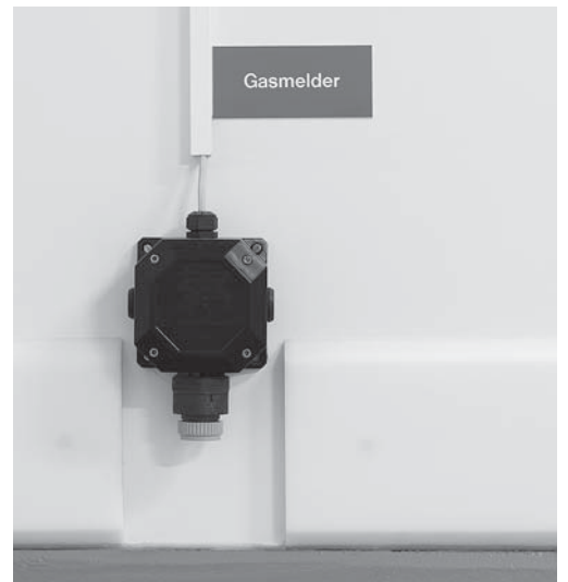
Bild 7: Gaswarnanlage
