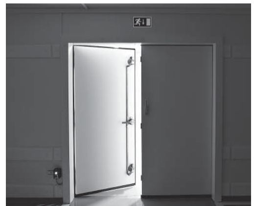
Bild 3: Notbeleuchtung (nachleuchtend)
